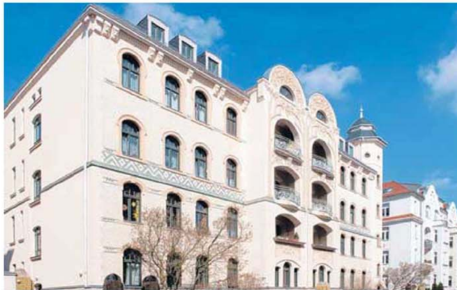
Wertgrund-Objekt in der Pölitzstraße im Leipziger Stadtteil Gohlis-Süd.
